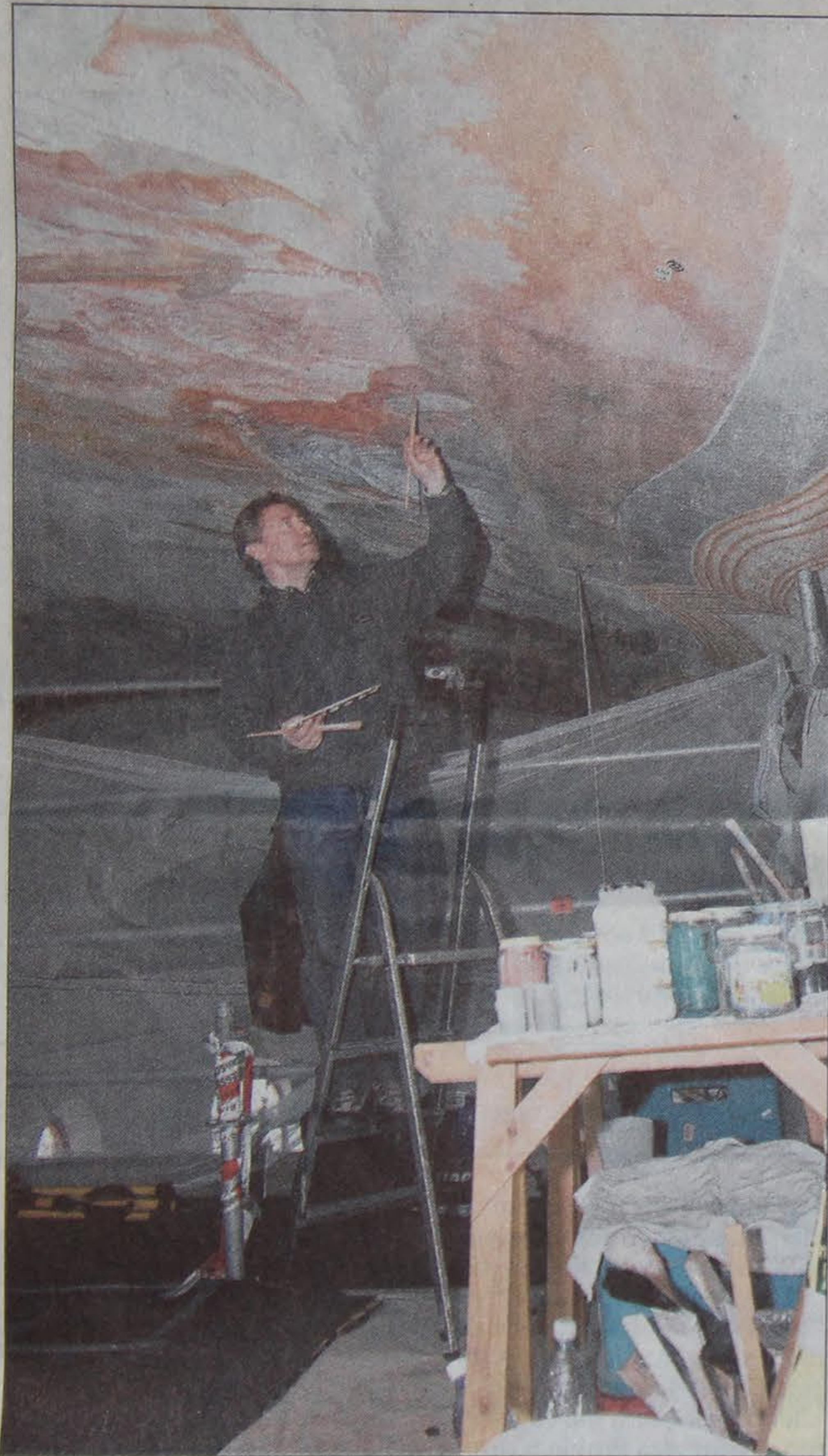
Kirchenrestaurator Wojtek Wellenger an seinem Arbeitsplatz rund 14 Meter über dem Boden von St. Peter und Paul. Dort ergänzt er gegenwärtig ein wertvolles barockes Deckenfresko. Gemalt wird auf feuchtem Putz – ein Fön beschleunigt mitunter den Trocknungsprozess. Foto: RMB / Margielsky
